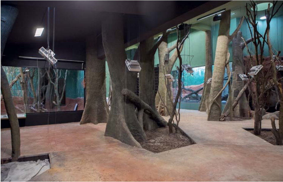
Rozmístění ledkových fotosyntetických svítidel s torkretovými stromy Placement of photosynthetic LEDs with shotcrete trees
