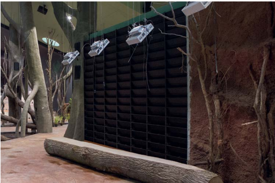
Technická konstrukce vegetačních stěn z plastových kaskádových truhlíků Technical design of vegetation walls made of plastic planters in a cascade
